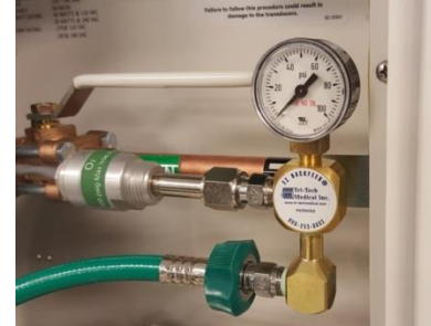
Accesorio E Z Backfeed™ de dos puertos con manómetro, transductor y manguera de retorno colocada en la válvula de demanda específica de gas DISS que se muestra más arriba
